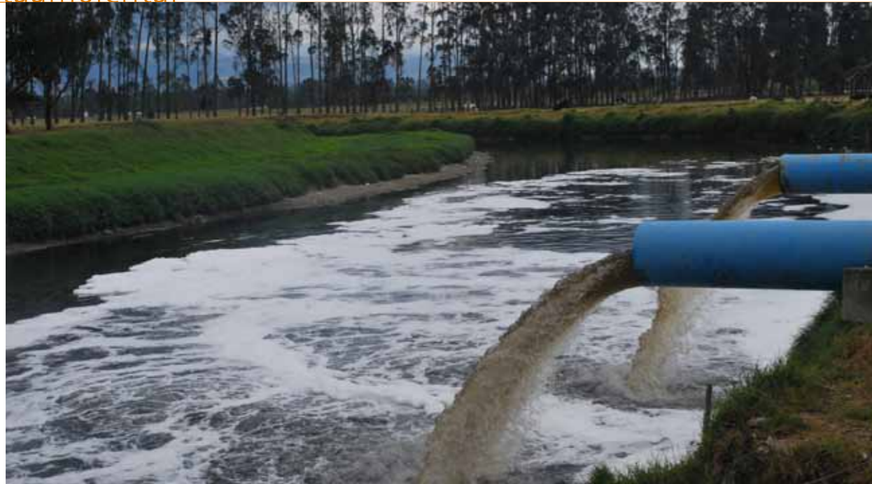
Vertimiento zonas industriales.
