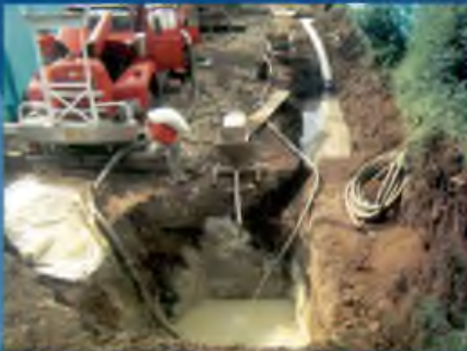
Zanjas de lodos en el proceso de perforación
