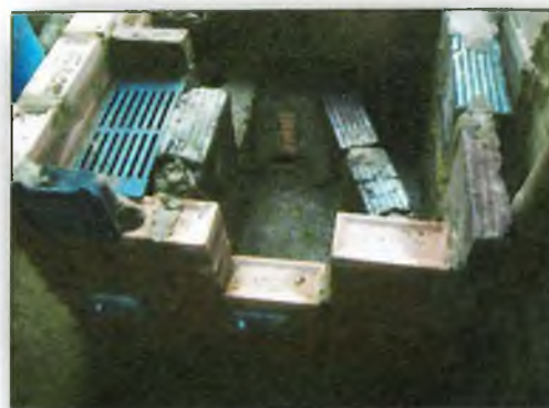
1. Establecimiento de la estructura externa e interna de la estufa.
