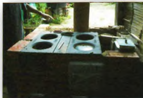
3. Realización de acabados y terminación de la estufa
